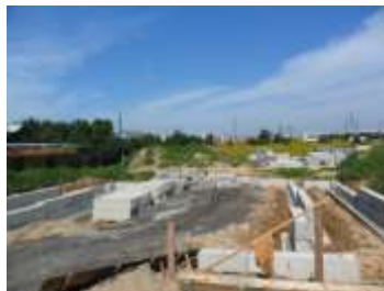
De bouw is begonnen (augustus 2011)
